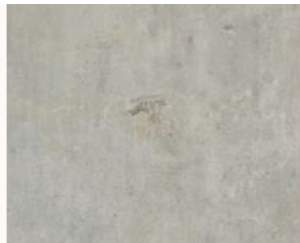
S-03 béton S-03 béton
